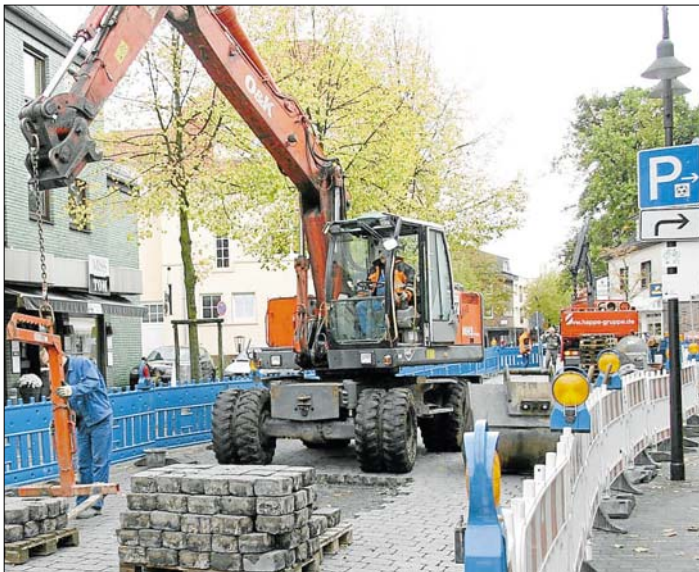
Die ursprünglichen Pläne der Stadt hinsichtlich Breitband-Versorgung kollidieren mit EU-Recht. Jetzt will man die Leerrohre für die Glasfaserkabel selbst verlegen lassen, um das Geschäftsfeld in Verl für Telekommunikationsunternehmen attraktiv zu machen und Wettbewerbsregeln einzuhalten. Bild: von Stockum
